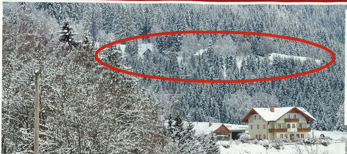
Im Bereich „Waldmann“ entsteht der untere der beiden Speicherseen (siehe Markierung)
